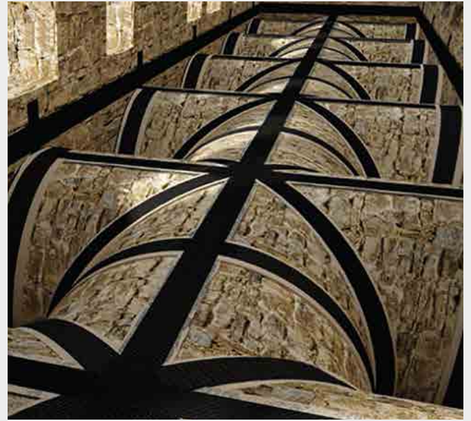
CONSOLIDAMENTO DI ARCHI E VOLTE
