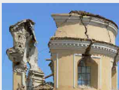
Il tamburo messo in sicurezza. A lavori di restauro compiuti i cavi sono stati facilmente rimossi.
