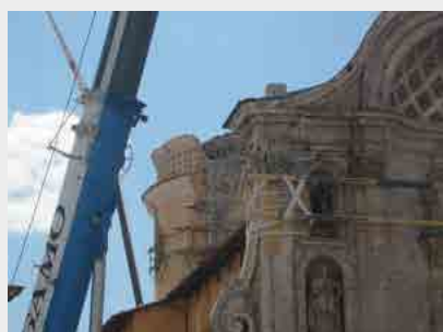
Fase dei lavori di messa in sicurezza della struttura
