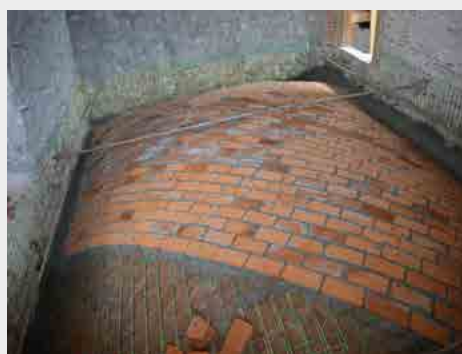
Fasi di realizzazione dell'intervento di rinforzo
