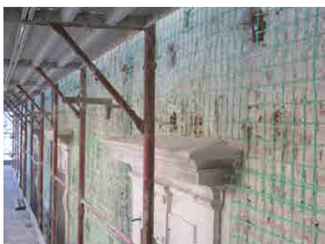
Fasi di realizzazione dei rinforzo delle murature con sistema CRM RI-STRUTTURA
