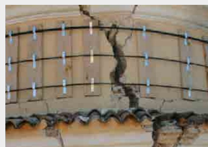
I cavi Betontex Tie disposti alla sommità del tamburo.
