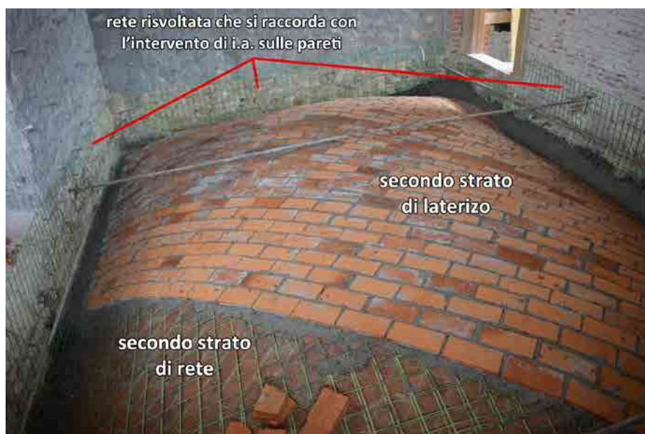
Posa del secondo strato di laterizio.
