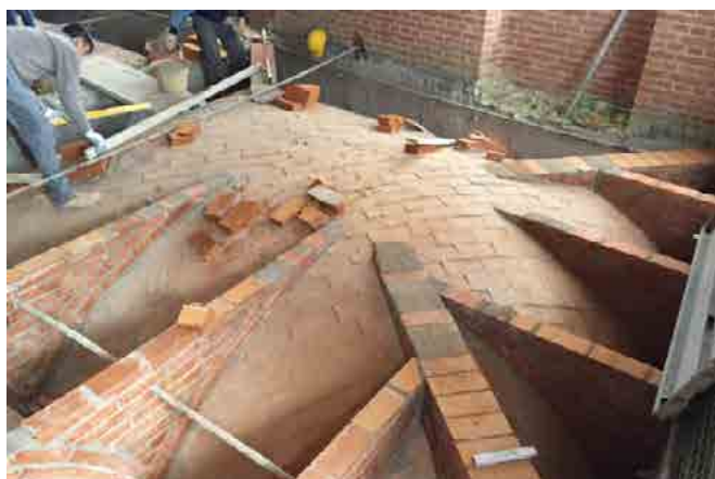
Disposizione dei tiranti e realizzazione dei frenelli.
