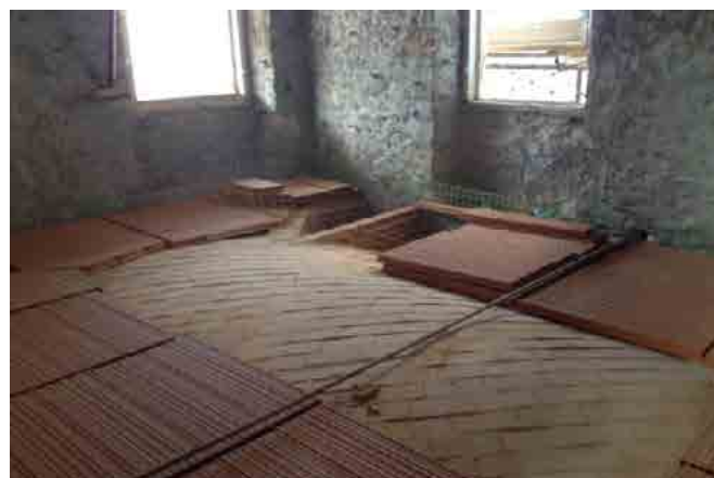
Posa dei tavelloni per la realizzazione della pavimentazione.
