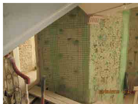
Fasi di realizzazione dei rinforzo delle murature con sistema CRM RI-STRUTTURA
