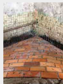
Fasi di realizzazione dell'intervento di rinforzo
