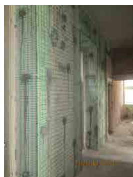
Fasi di realizzazione dei rinforzo delle murature con sistema CRM RI-STRUTTURA
